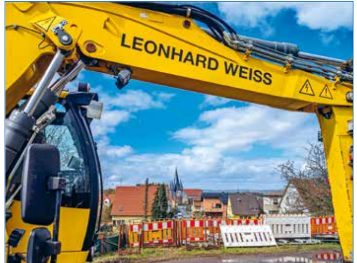
"Bahnbaustelle"; Foto: Stefan Thiel
