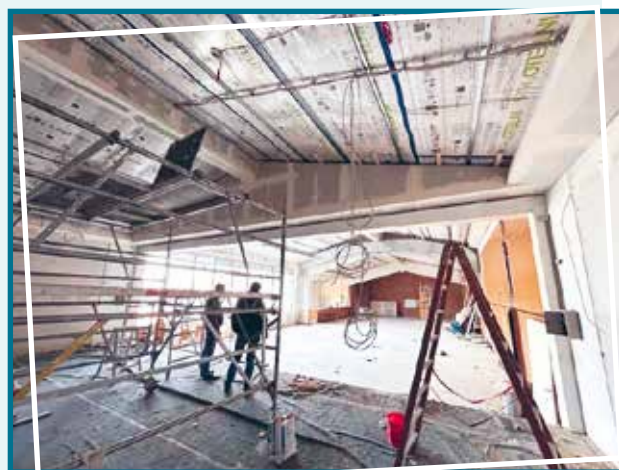
Die Sanierung Bürgerhauses in Großseelheim schreitet weiter voran
